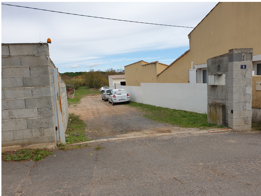
Figure 9 : Maisons devenues inondables du quartier Fontmajou à Bessan
